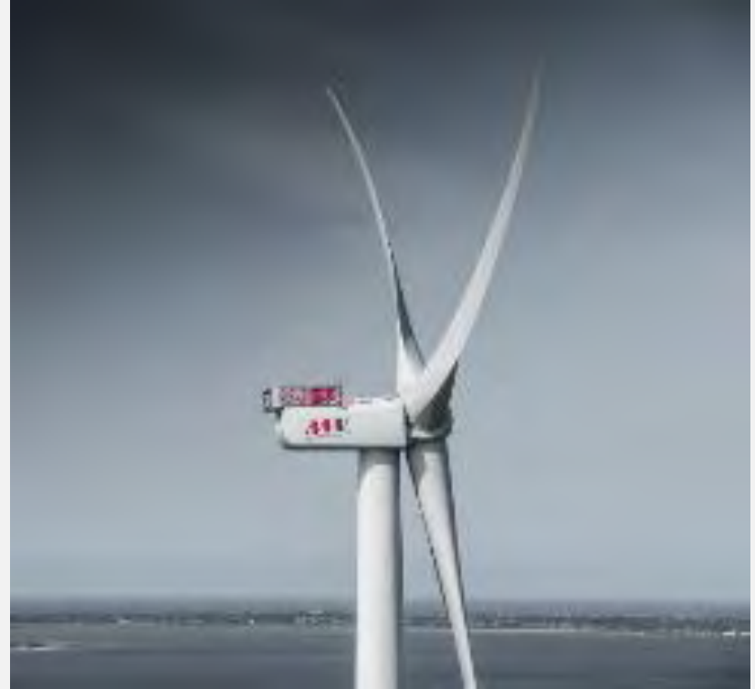
MHI Vestas V164-9.5 MW
